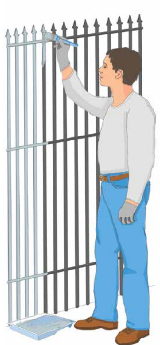
PINTURA DE ELEMENTOS METÁLICOS
